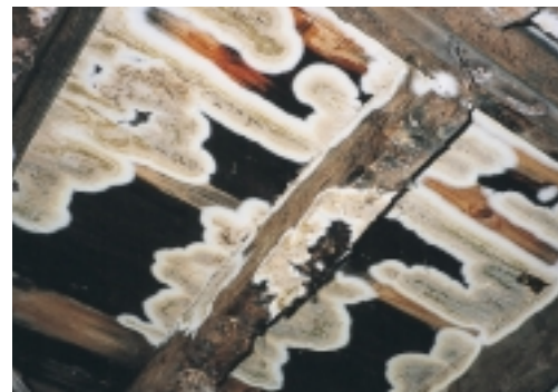
Kelderzwam - vruchtlichamen. Deze vruchtlichamen worden makkelijk verward met die van de huiszwam
