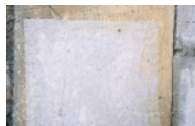
Papier geplakt over een aantal uitvliegopeningen om zo de activiteit te bepalen. In het papier onder zit een gaatje en dus is de aantasting actief. Boven gaat het om een oude, niet-actieve aantasting
